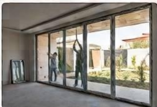
۱۳. نصب درب، پنجره و تجهیزات
