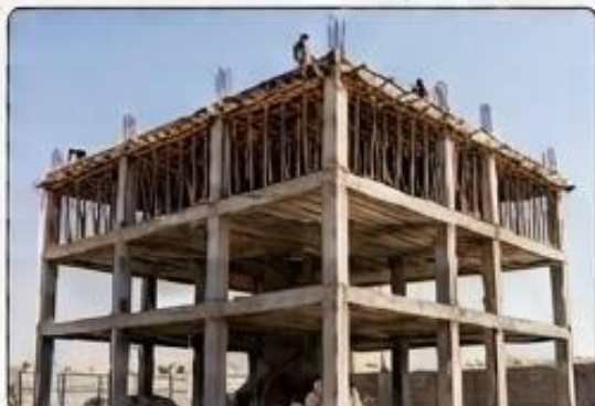
۷. اجرای اسکلت (بتنی)
