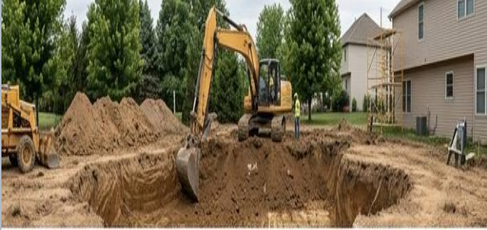
زیرسازی و آرماتوربندی
